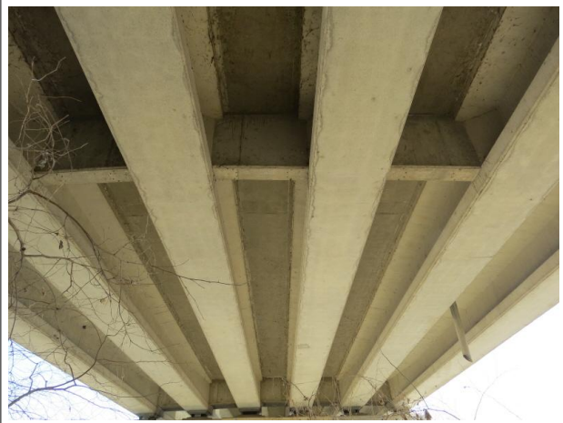
바닥판, 거더, 가로보 전경
