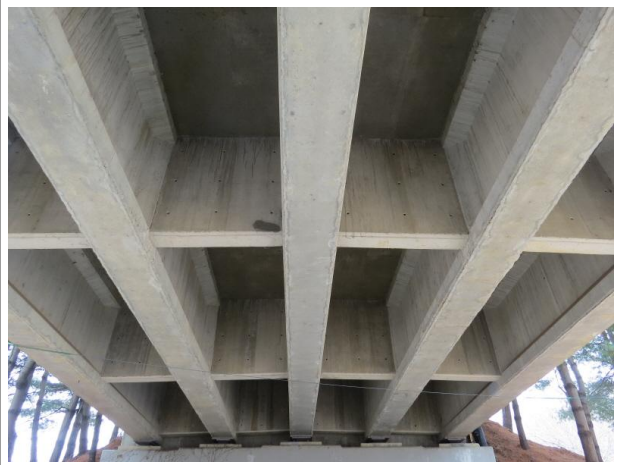
바닥판, 거더, 가로보 전경
