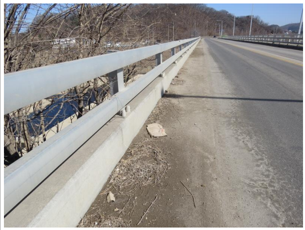
난간 및 연석 전경
