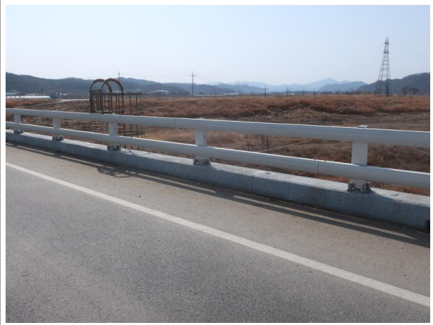
난간 및 연석 전경
